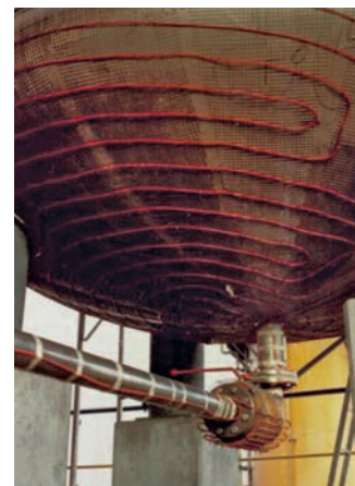
Anwendungsbeispiel einer Rohr- begleitheizung
