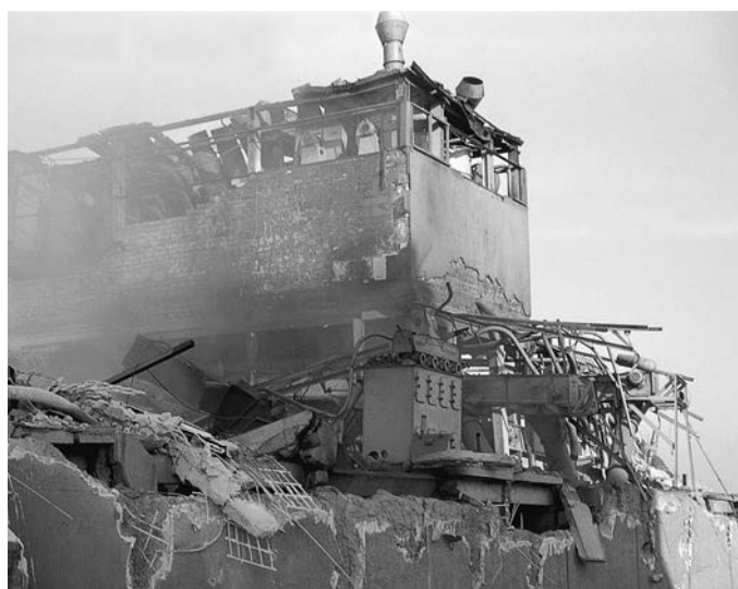
Folgen einer Staubexplosion: Rolandsmühle, Bremen
