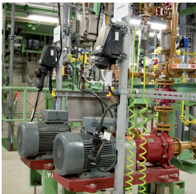
Elektrische Maschinen: Steckbar angeschlossene Pumpenantriebe in der Zündschutzart „nA“
