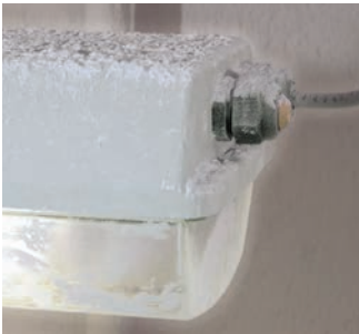
Staub-Zündschutzart durch Gehäuse „t“: Langfeldleuchte im staubexplosionsgefährdeten Bereich
