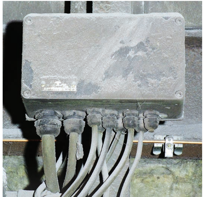
Beispiel Staub-Ex-Zone 21: Explosionsgeschützter Klemmenkasten
